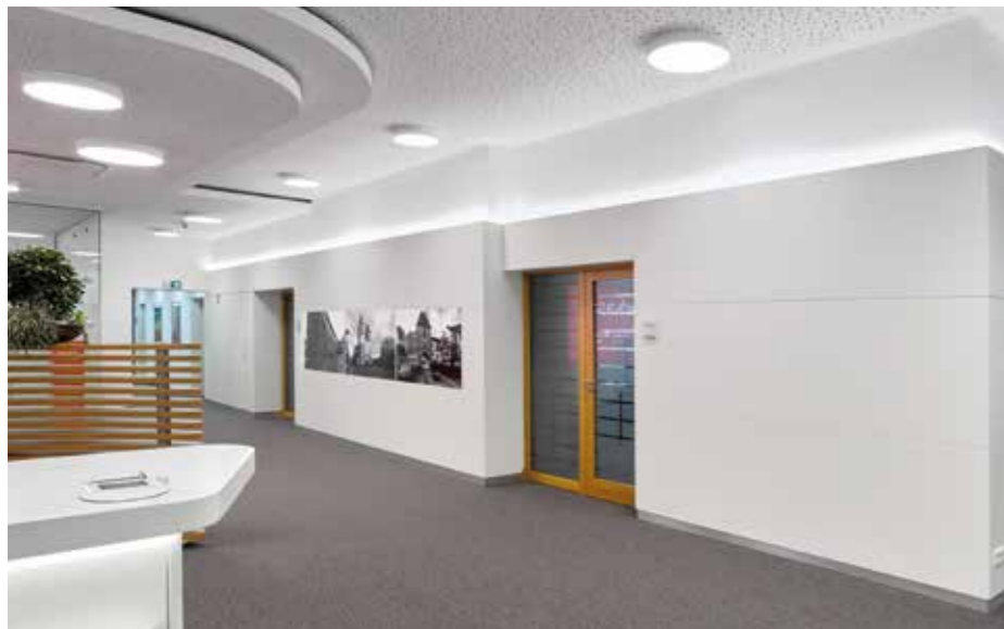
▲ Neue Wandvertäfelung mit integrierter Bestandstür in Holz
