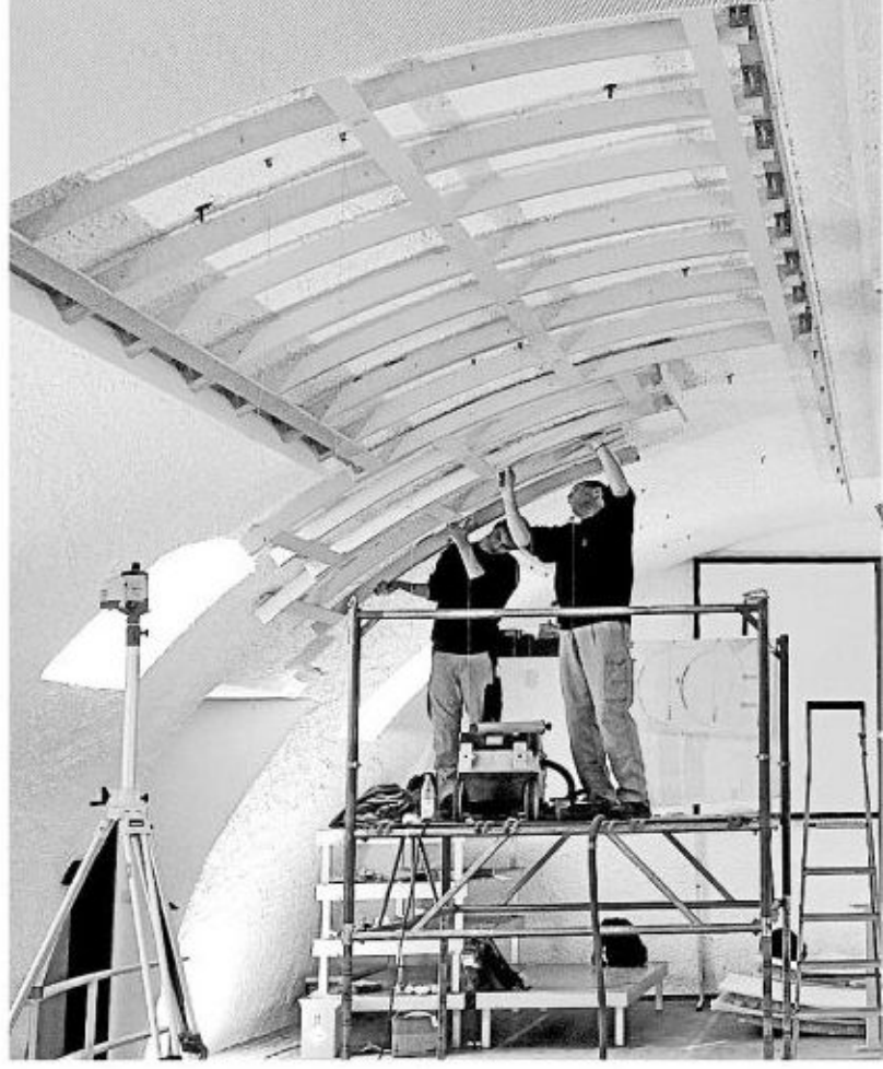
Mitarbeiter einer Fachbacher Schreinerei installieren im Brauereikeller das Holzgerüst, das die Schall absorbierende Konstruktion tragen soll. Sie verbessert die Akustik in dem Saal.
